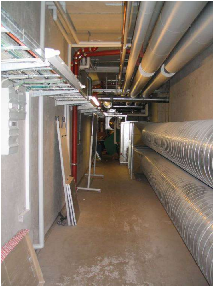
Eksempel på veldisponeret føringsvej til installationer
